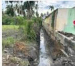
Limpieza y saneamiento alcantarillado frente al 8 mayo, 2024
